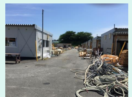
仮設取り壊し風景
