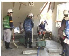
汚泥除去作業
