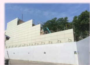
2014年安渡小学校解体工事
