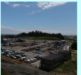
城内高台工事
