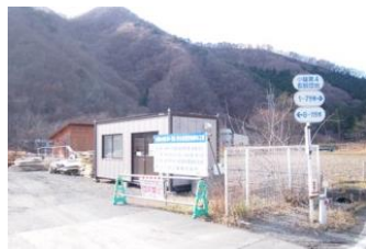
解体中のエコハウス
