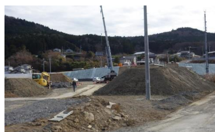
鮎川の道路工事
